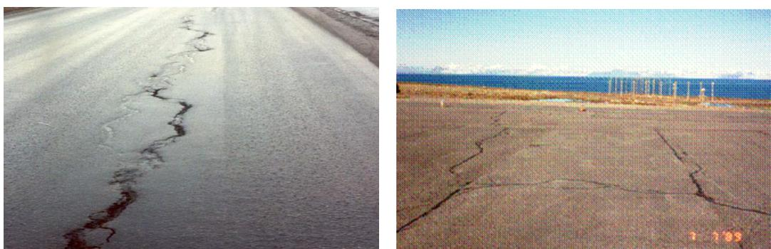
Figure 1. G. Fissuration par retrait thermique. D. Fissuration réfective d'une chaussée fondée sur dalles béton. Norvège (Watn, 2011).
